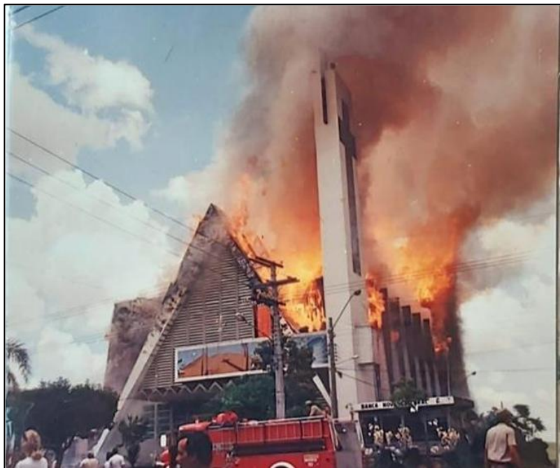
Figura 7.2: Figura 2 – Imagem do incêndio que destruiu o prédio em 24/11/1990.
