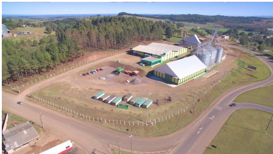
Figura 1.1: Vista aérea da Cooperativa Cooperar Insumos Agrícolas.
